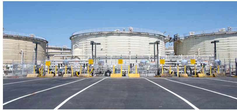
Una estación de servicio de hidrógeno en Oakland, California. Crédito: sheilaf2002 / stock.adobe.com
