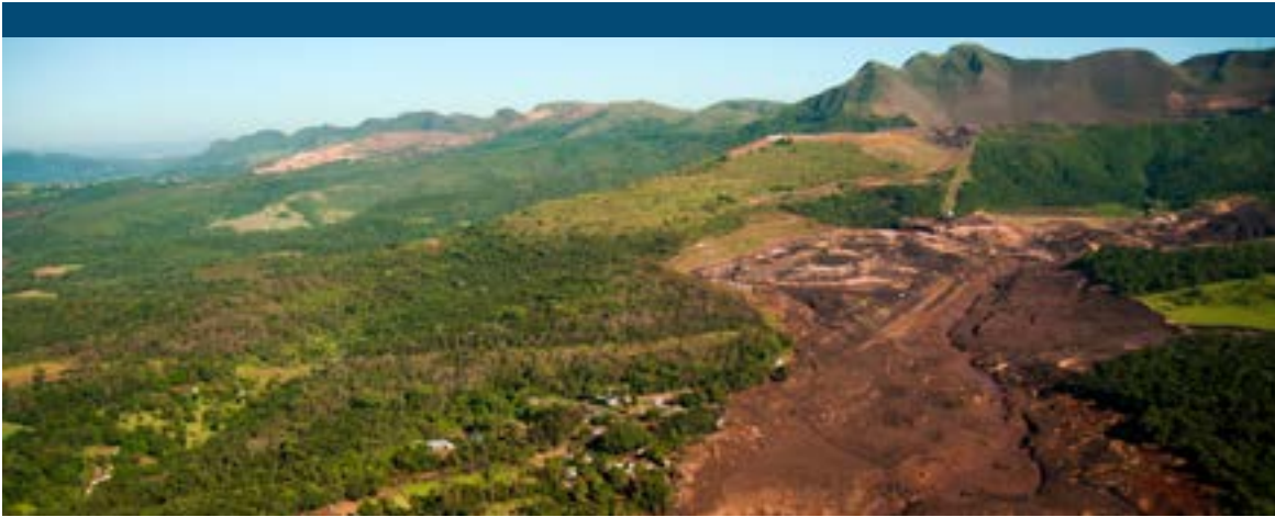
Consecuencias del derrumbe de la presa de Córrego do Feijão | Foto © Ilana Lansky/Shutterstock.com
